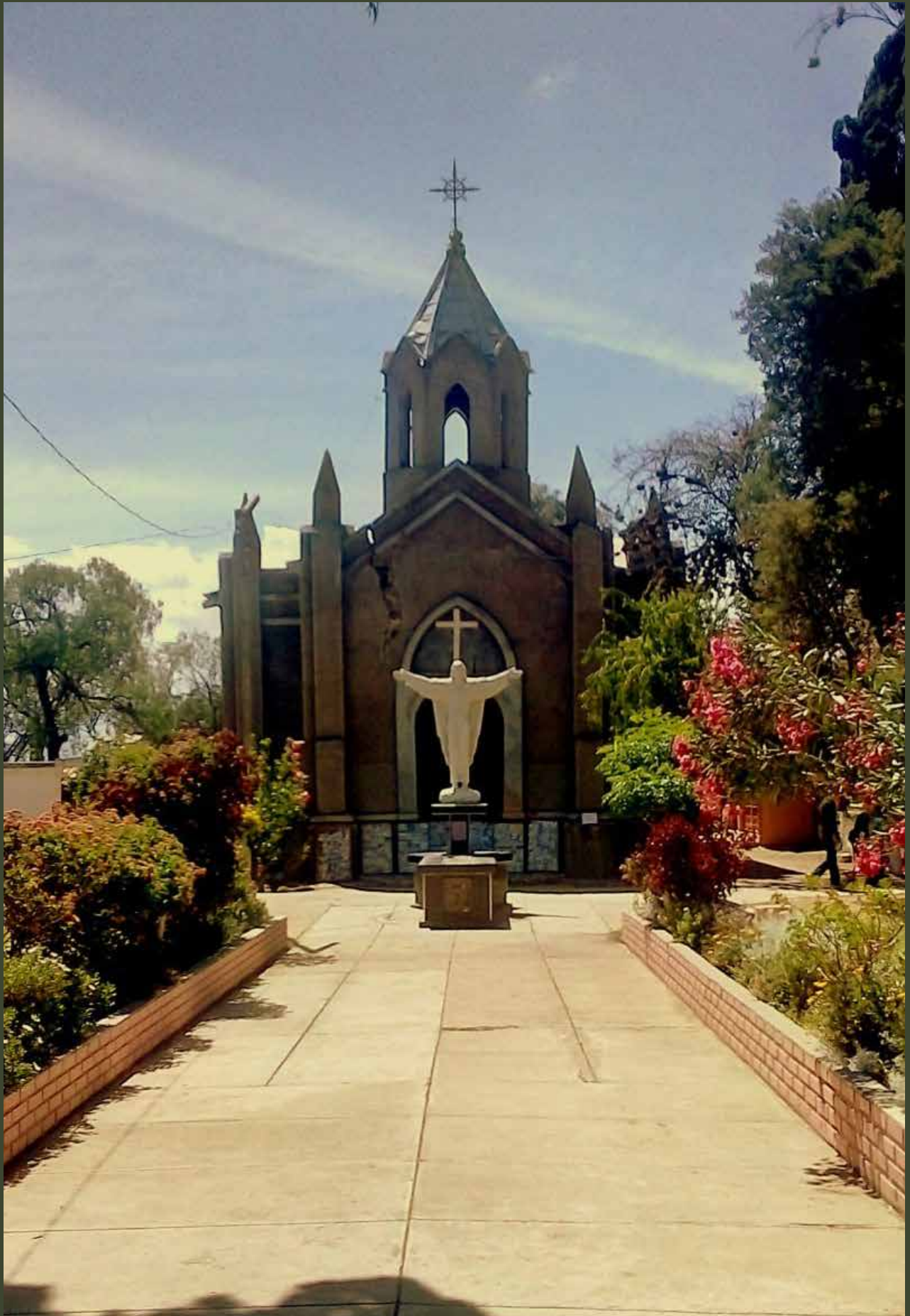
Paisaje de jardines en el área de Capilla. Delante se halla la figura de Cristo Redentor. En 2021, la capilla fue cerrada debido a peligro de derrumbamiento. Nótese la grieta en la pared frontal.
